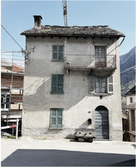
Edificio di nucleo con dettagli
