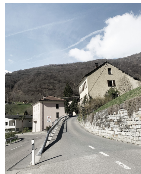
Vista dell'edificato su strada
