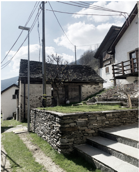
Terrazzamento in muro a secco
