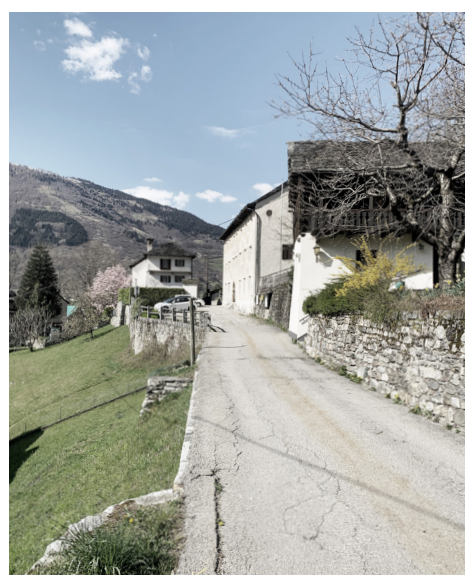
Vista dell'edificio verso nord
