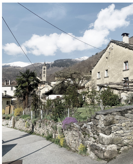
Terrazzamento in muro a secco
