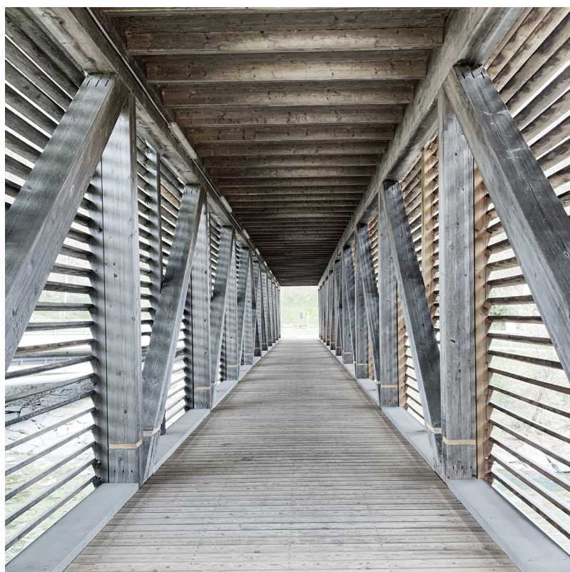
Ponte pedonale tra Dongio e Corzoneso
