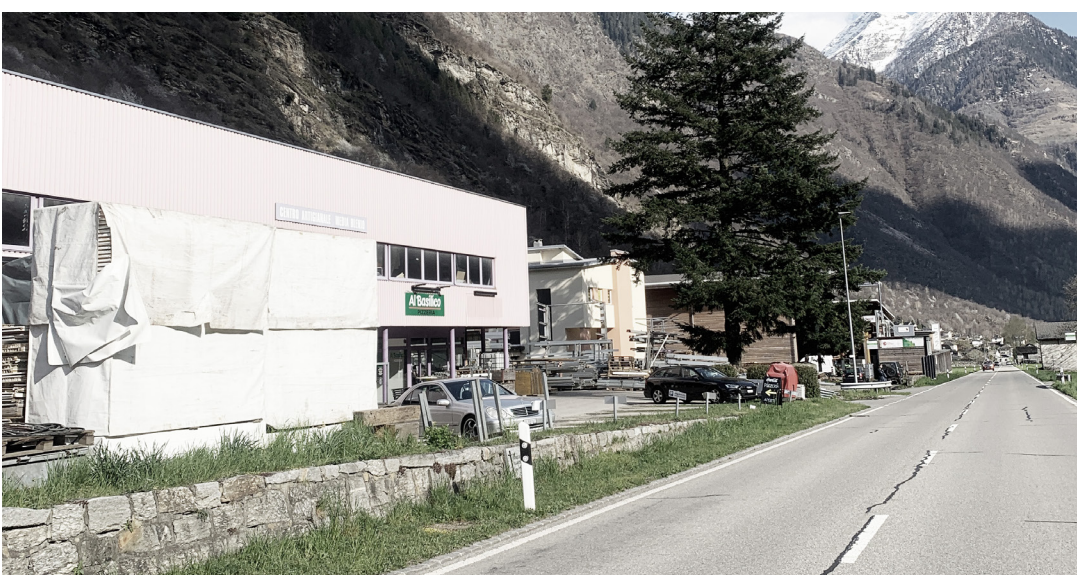
Vista della zona lavorativa a Dongio dalla strada cantonale
