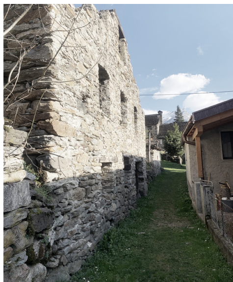
Rovine edificio rurale
