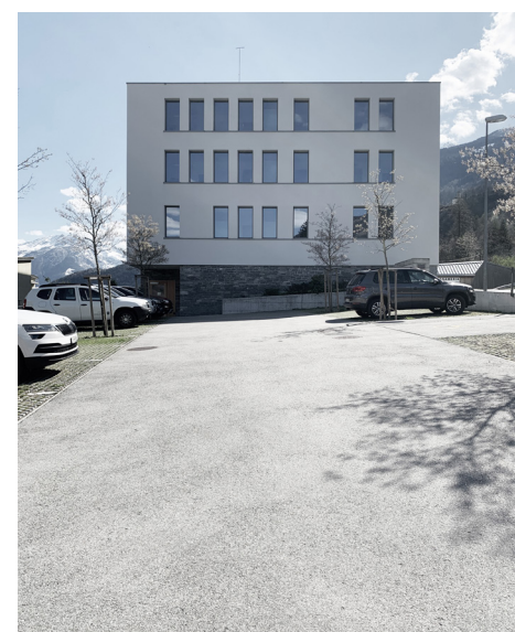
Vista del posteggio del Municipio
