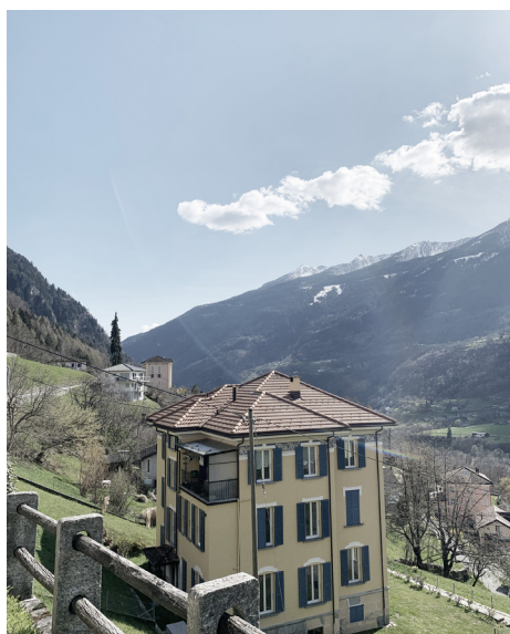
Edificio di pregio in rapporto col paesaggio
