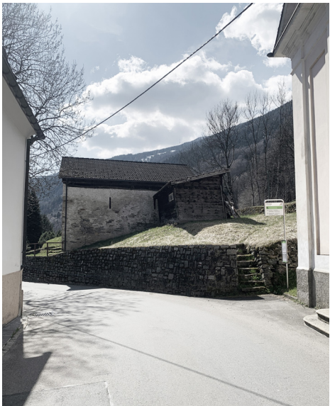
Terrazzamento in muro a secco
