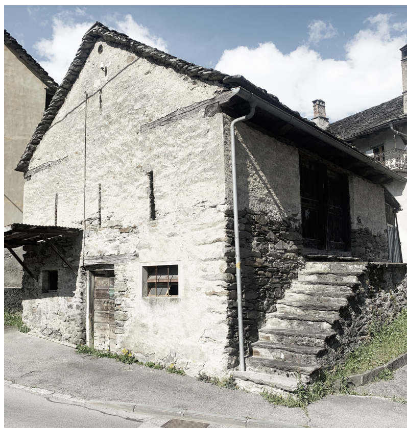
Edificio rurale a Prugiasco
