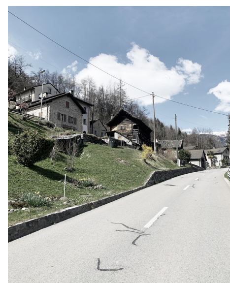
Vista dalla strada della struttura edificata
