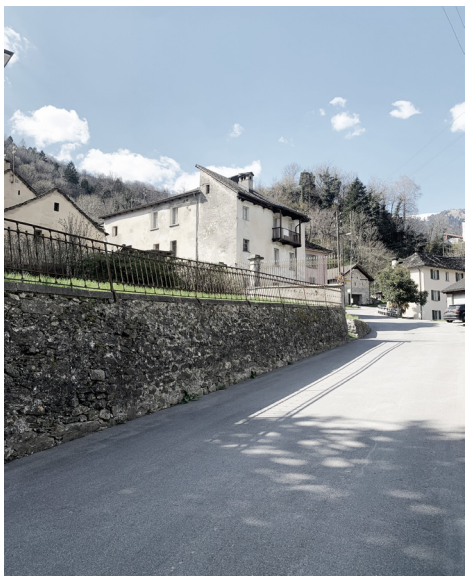
Terrazzamento in muro a secco
