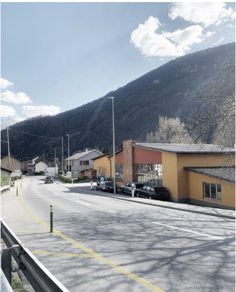
Vista dalla strada sull'edificato
